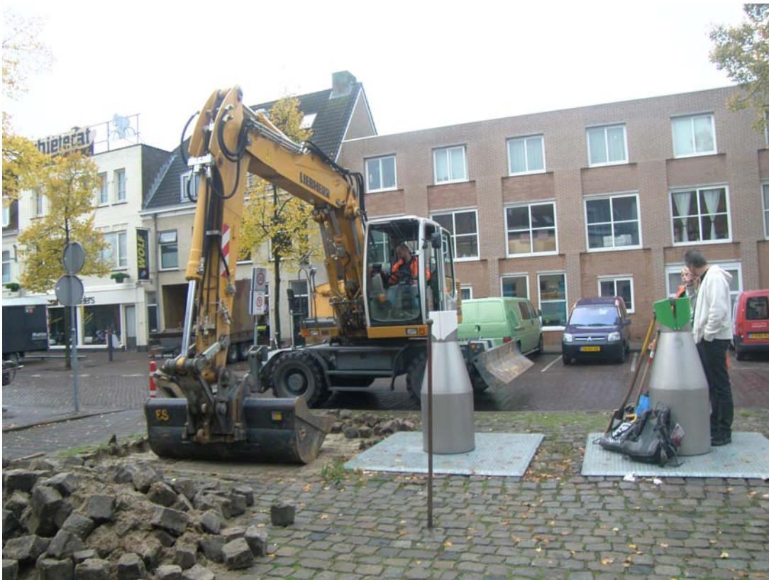
Afbeelding 8. Aanleg werkput naast de glascontainers waar in 2010 begeleidend onderzoek is uitgevoerd.
