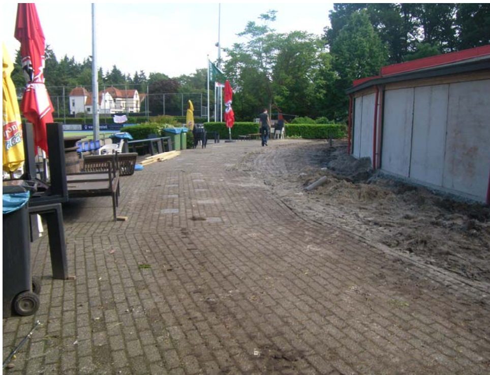
Afbeelding 6 Werkzaamheden langs het huidige clubgebouw.
