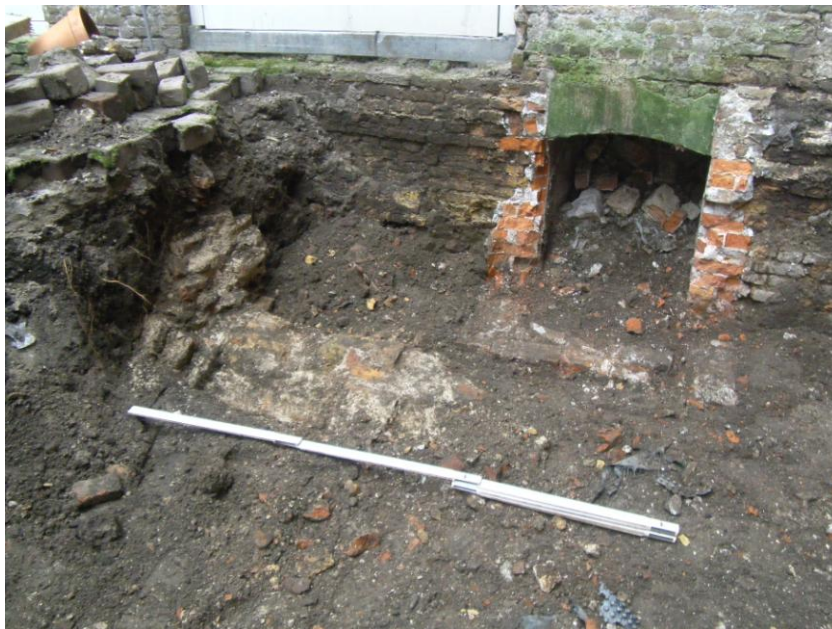
Afbeelding 10 Ingang tot kelder of regenwateropvangputje onder pand Veemarktstraat 7.
