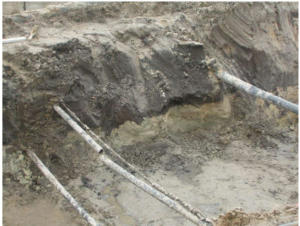
Afb. 9 Het oostelijke deel van de Laurentius- straat waar het dek- zand onder een 20- 40 cm dik pakket recente bouwvoor lag
