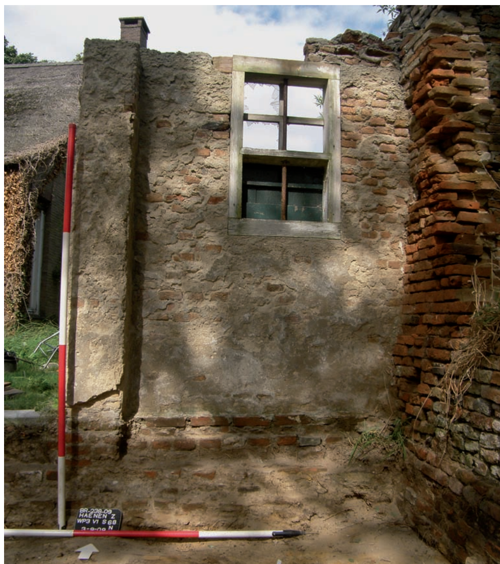
Afb. 20 Fundamenten van de noordgevel van het bakhuis (S 068) met links de natuur- stenen dorpel, en rechts het raamkozijn.
