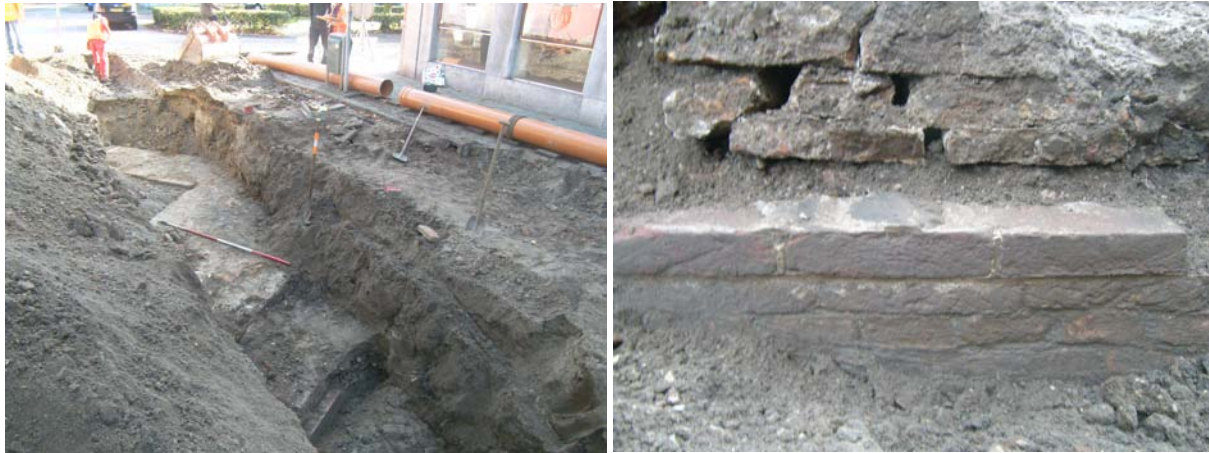
Afb. 9. Rechts muurwerk van ravelijn 'Prins Maurits' ter hoogte van Seeligsingel 1, links klampmuur.
