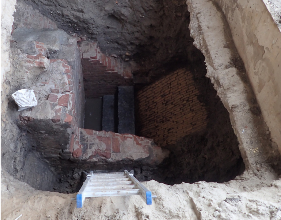
Afb. 42. Zicht op werkput 8, waarin de resten van een natuurstenen toegangs- trap tot het riool werden blootgelegd.
