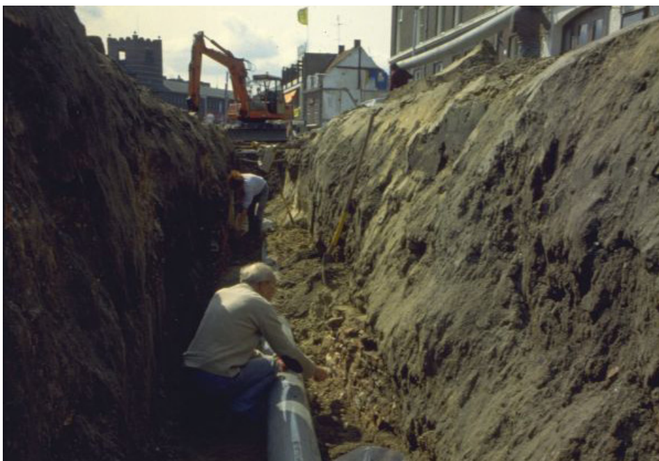
Afb. 12. Bij de aanleg van een gasbuis in 1983 kwam de stasmuur in zicht ter hoogte van de Oude Vest/Kloosterplein (BR-07-83). Voor in beeld is de stadsmuur te zien.
