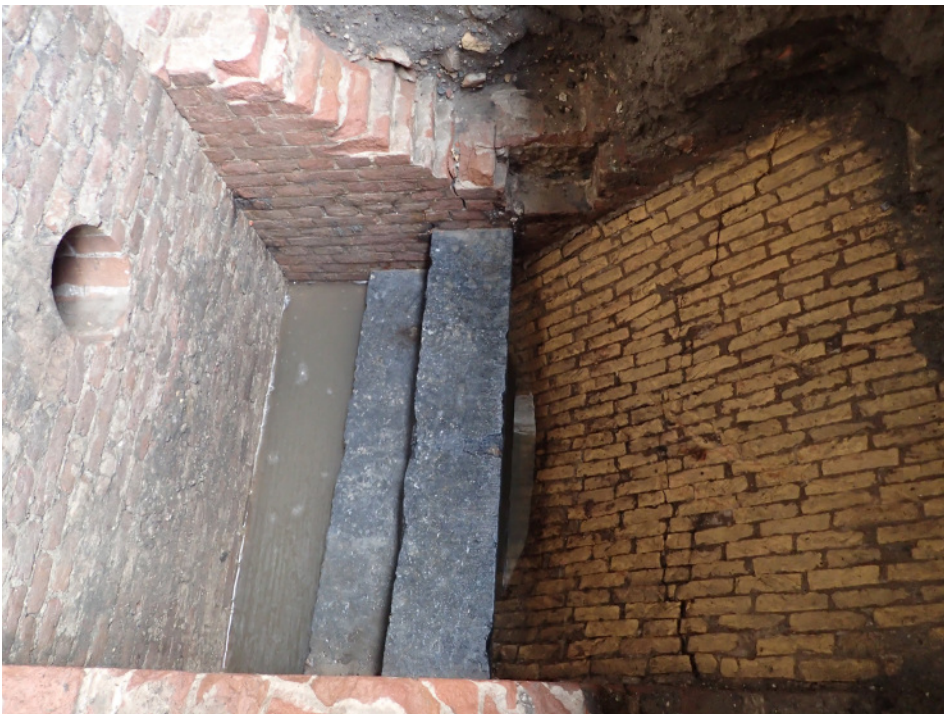
Afb. 43. Links in beeld de dicht- gemetselde toegang met opening voor een rioolbuis, rechts de uit ijsselsteentjes gemetselde helling onder de trapredes.
