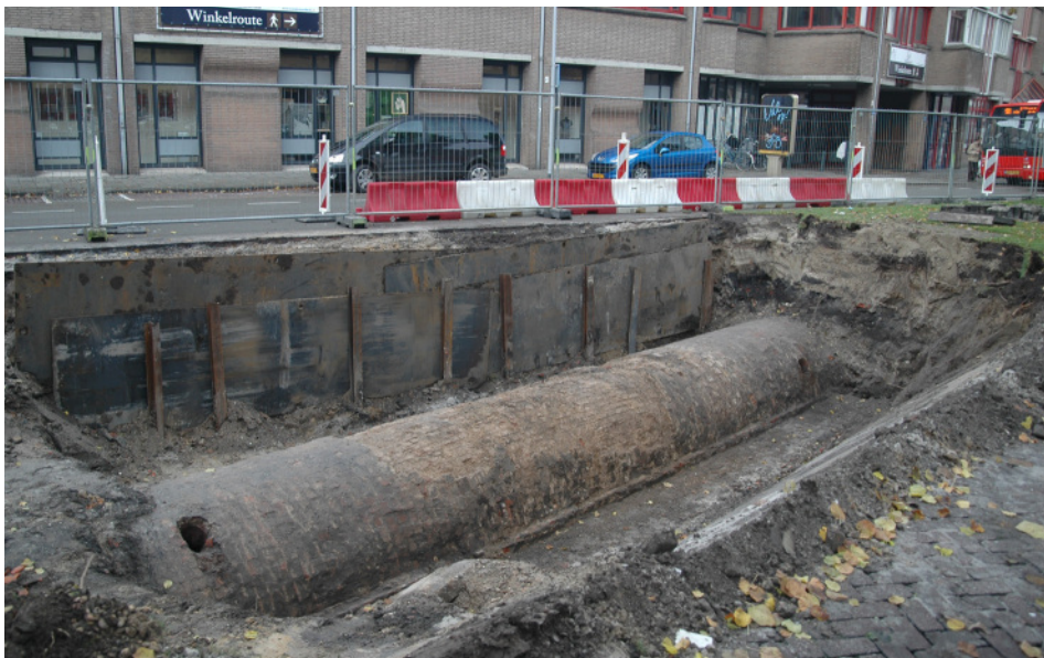
Afb. 11. Voor werkzaamheden vrijgelegd onder de Vlaszak: het negentiende eeuwse historische riool (BR-256-09).
