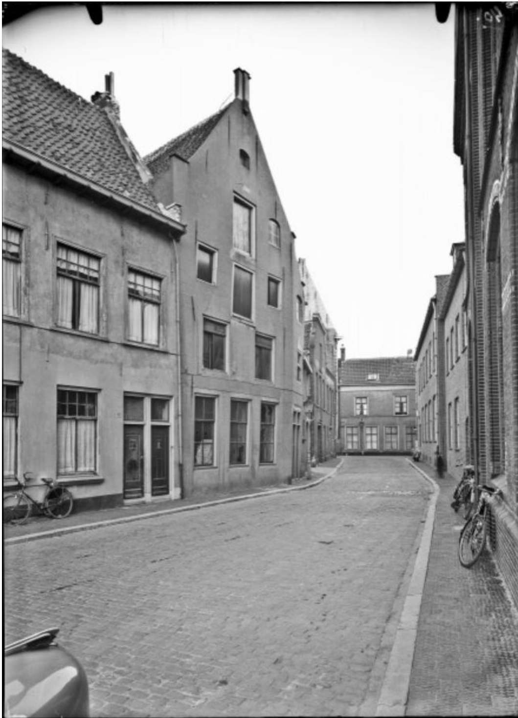
Afb. 3, Zicht op de Kraanstraat vóór de sloop met aan de linkerkzijde het latere opgravingsterrein (foto: beeldcollectie Stadsarchief Breda, GN19880043)
