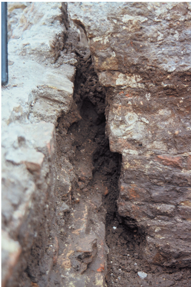
Afb. 7: ruimte tussen de voorgevel en de binnenmuur.
