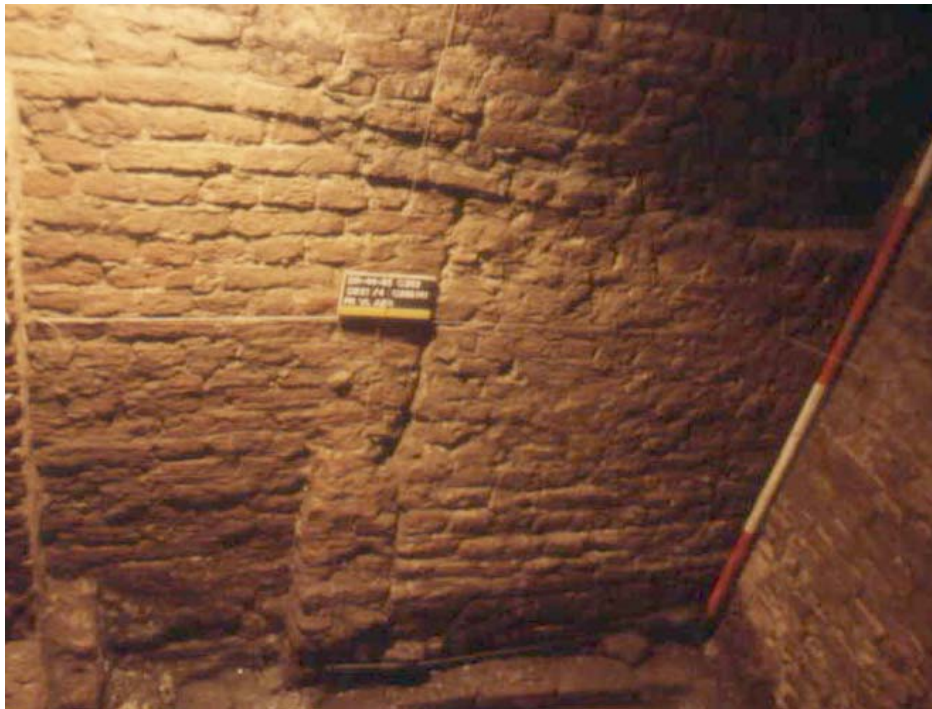
Figuur 7: Muurwerk behorend bij fase 2 (1325-1425) met sporen van een dichtgezette ingang in de noordwesthoek.
