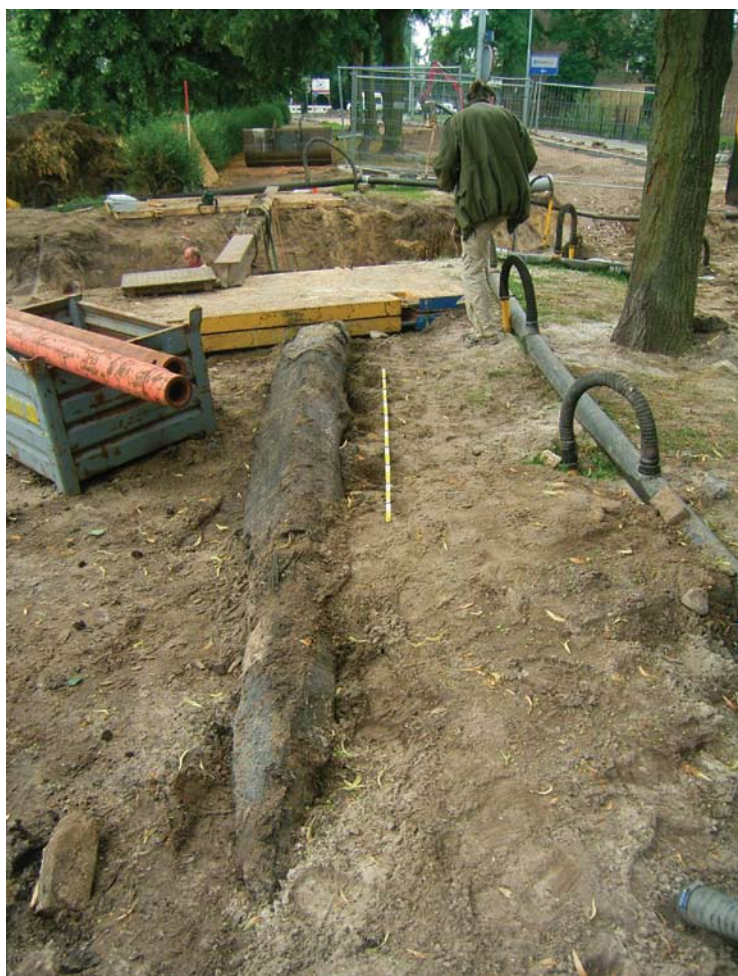
Afb. 5 De lange aangepunte paal aangetroffen bij de werkzaamheden op de hoek Weerijssingel/Verlaatstraat
