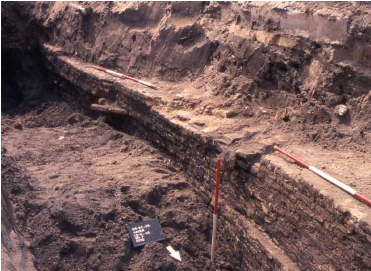
Afbeelding 13 Kromming stadsmuur C702, verankerd aan kademuur C707. Naar het zuidwesten
