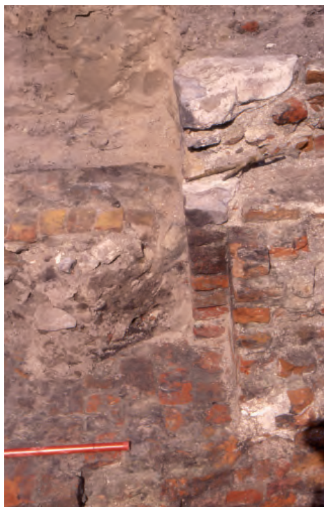
Afb. 15.5. De zuidelijke deurpost, met natuurstenen stootblok.
