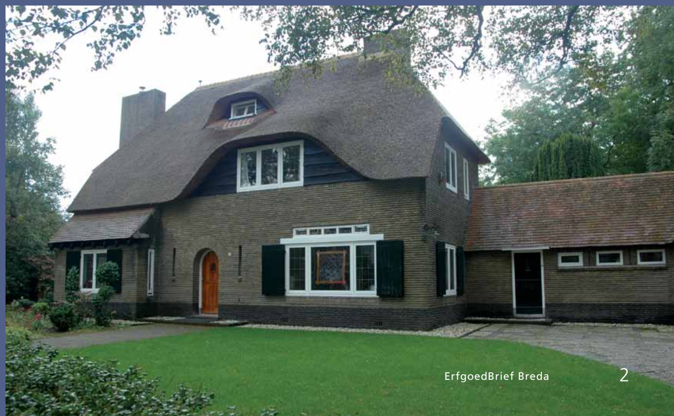
De voormalige burgemeestersvilla van Princenhage aan de Laan van Mertersem, een gemeentelijk monument.
