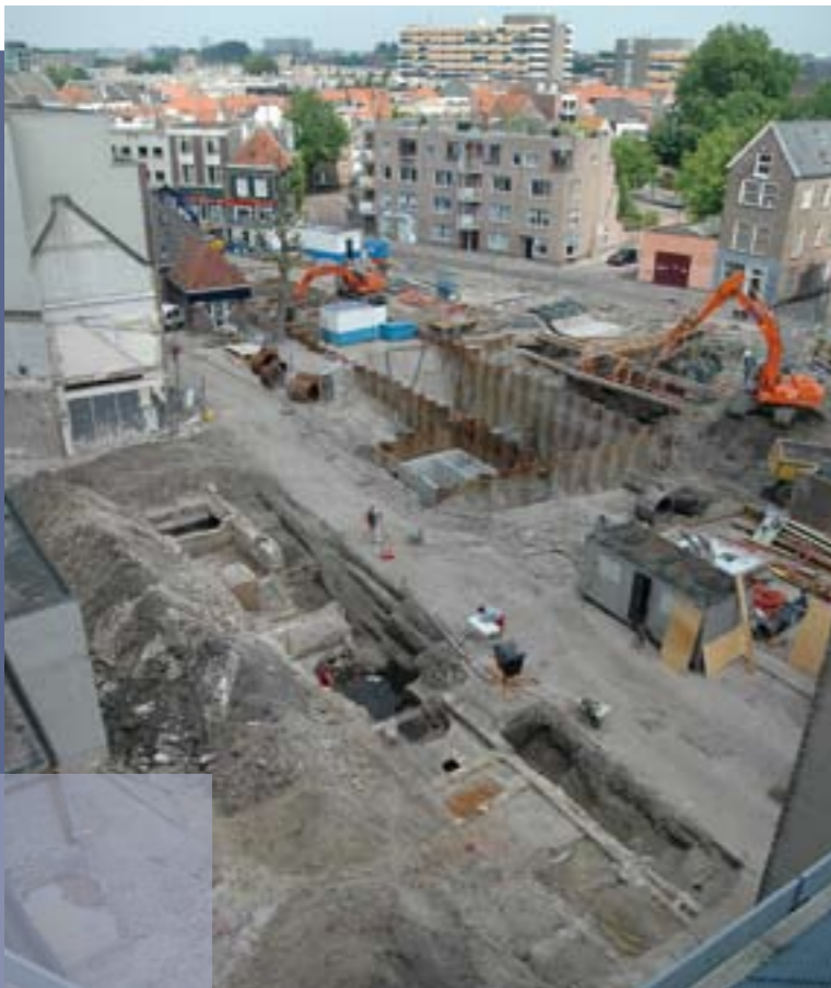
De funderingen van de kelders uit de zeventiende eeuw aan de Nieuwe Weg zijn duidelijk zichtbaar.
