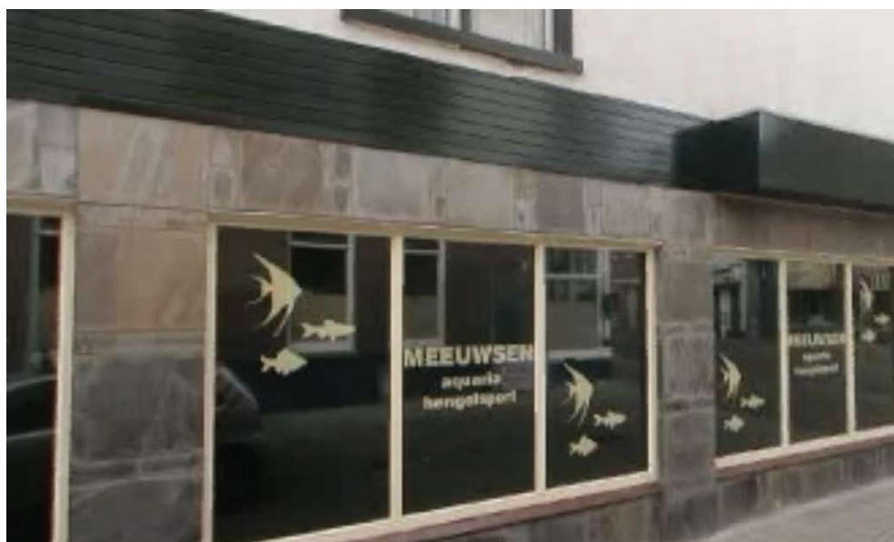
Afb. 2 Voormalige bebou- wing Haagdijk 145 / Pelmolstraat 4
