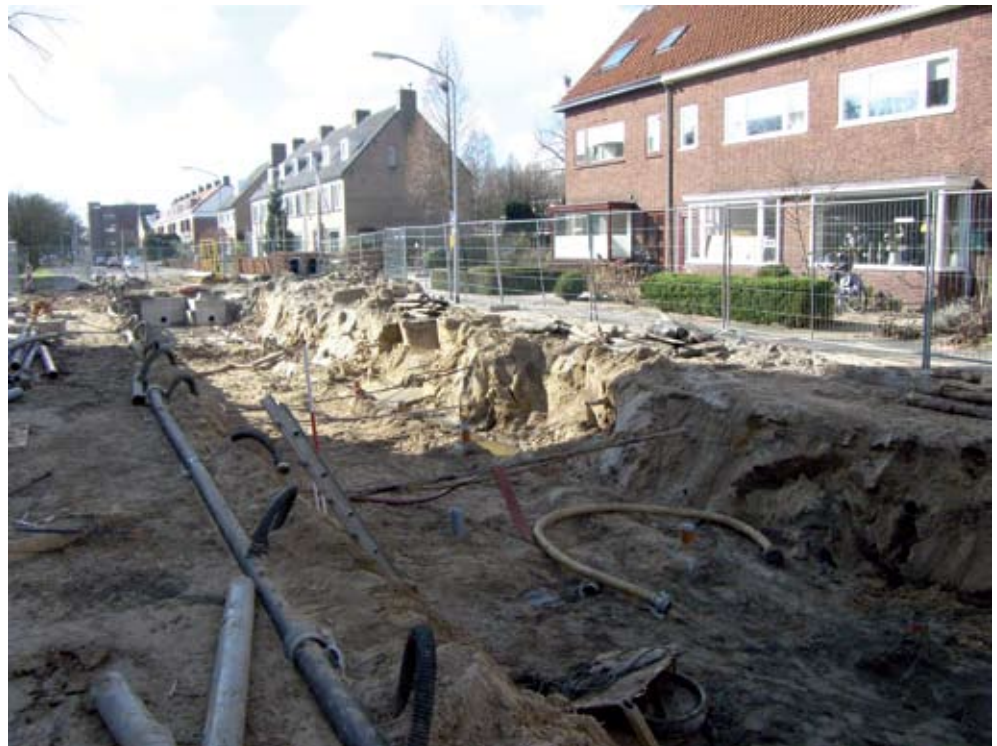
Afb. 7 Sfeerimpressie van de rioolwerkzaamheden aan de Brederostraat ( www.watwaswaar.nl )
