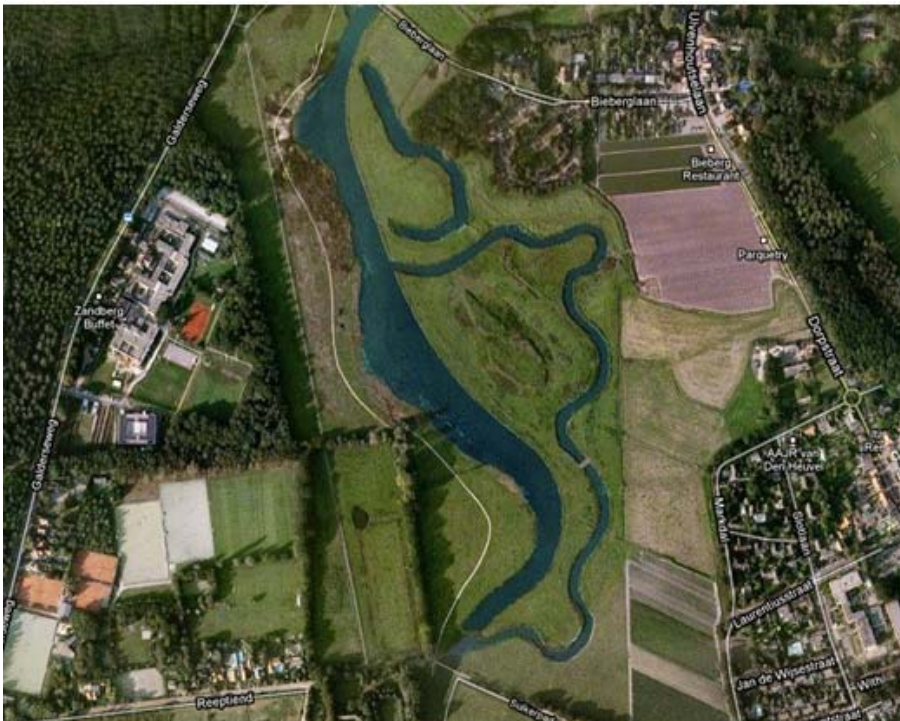
Fig. 32: het huidige Oud Hof, na de herinrichting. De grachten zijn licht uitgediept en de eilanden circa een meter opgehoogd, waardoor er een licht reliëf zichtbaar is in het landschap, wat wordt versterkt door de variatie in begroeiing.
