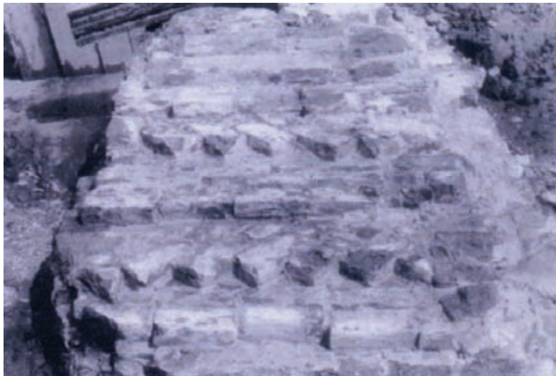
Afb. 11. Voorbeeld doorsnede van een muur met kruislagen (Gruben 1995).
