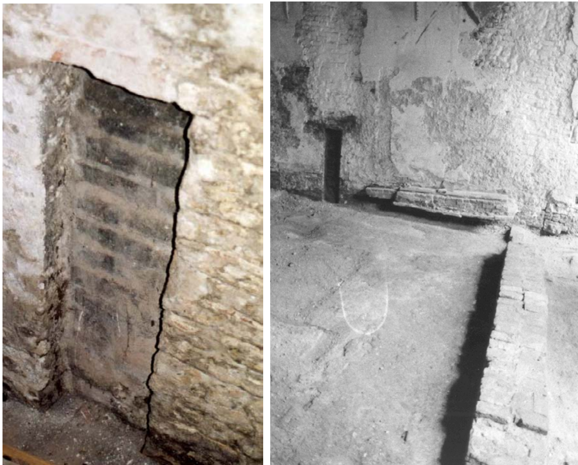
Figuur 96 & 97: Deel van de muursleuf (links) dat boven het vloerniveau zichtbaar is in de zuidgevel in de achterkamer; rechts een foto van de zuidgevel in de achterkamer met de muursleuf en het fundament van de oude achtergevel (foto's E. Koreman 1996 en 1984).
