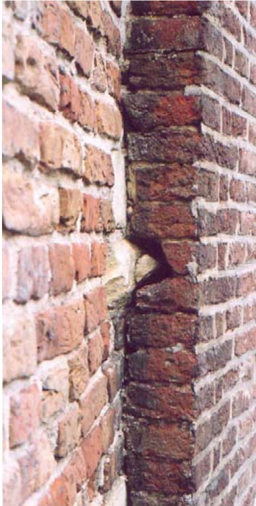
Figuur 52 & 53: Voorgevel met kantblokjes en in detail (rechts) het restant van de waterlijst die over de gehele breedte van de voorgevel heeft gezeten (foto's E. Koreman 2002).
