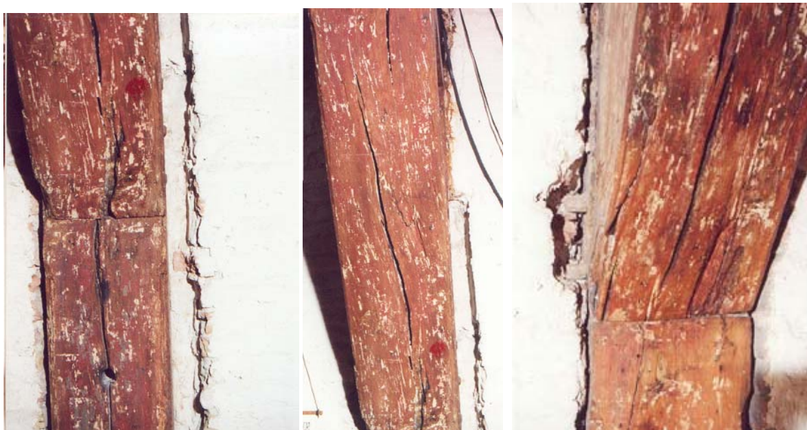
Figuur 106, 107, & 108: Details van muurstijlen met zichtbaar groter gekapte sleuven in muurwerk van 1490, soms deels dichtgezet (foto's E. Koreman 1994).
