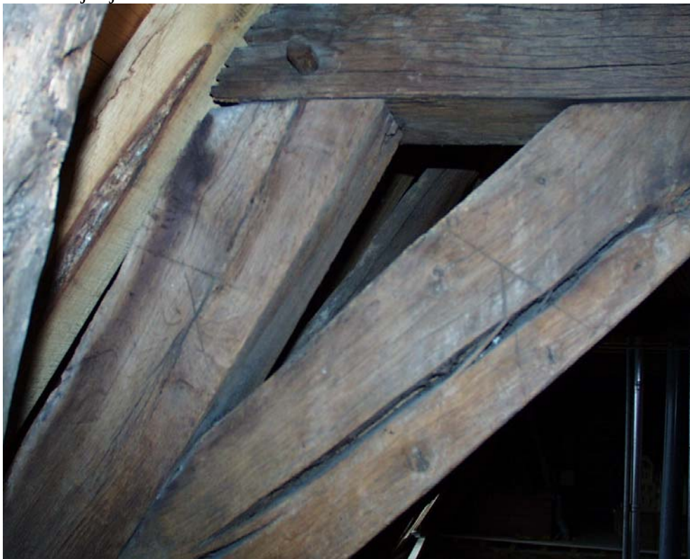
Figuur 126: Een deel van een kapspant met duidelijk zichtbaar de telmerken op het jukbeen en de jukbeenschoor.
