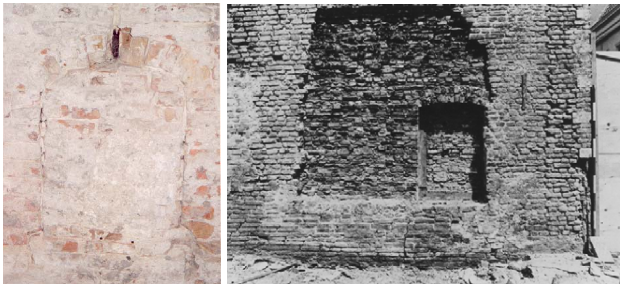
Figuur 65 & 66: Links: Dichtgezet raam met fragment van tralie in de zuidgevel (interieur) naast de schouw. Rechts: de schouw (exterieur) met duidelijk zichtbaar de dichtgezette doorgang naar het (gesloopte) pand Visserstraat 29 en de bouwnaad van de voorgevel (foto's E. Koreman en SAB).
