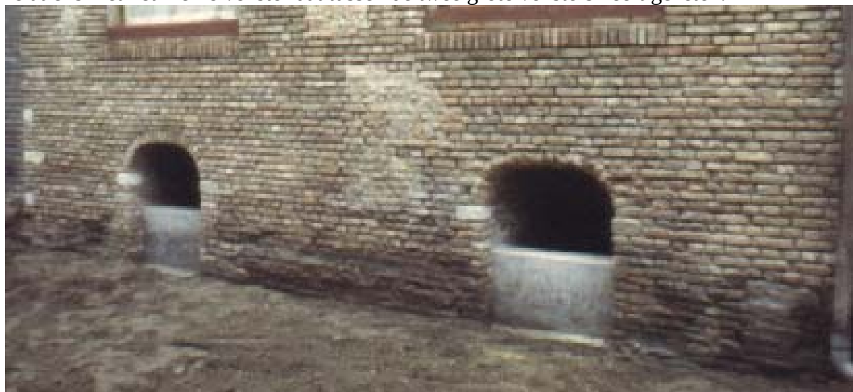
Figuur 59: De keldergaten na de restauratie in 1995 (Foto E. Koreman).
