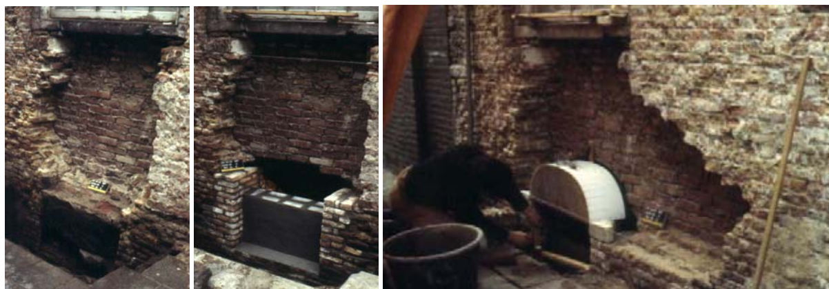
Figuur 48, 49 & 50: Het zuidelijke keldergat tijdens de restauratie in 1995; rechts is te zien welk gat er ooit in de gevel is gemaakt om een vliegwiel naar binnen te krijgen.
