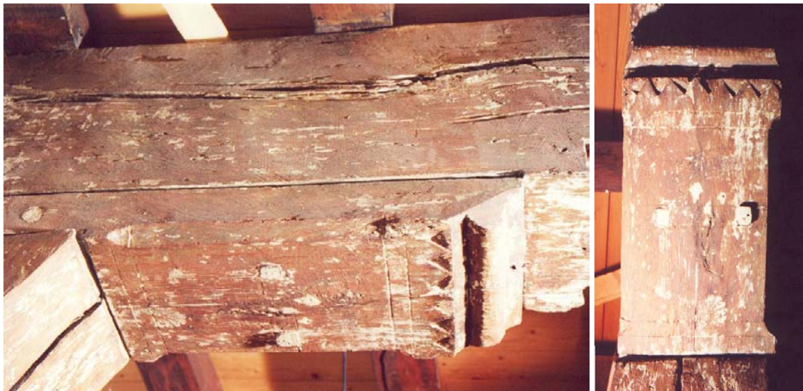
Figuur 99 & 100: Los sleutelstuk van moerbalk in voorruimte op eerste etage; zichtbaar zijn versiering, toognagels en kraslijnen (Foto's E. Koreman 1994) .
