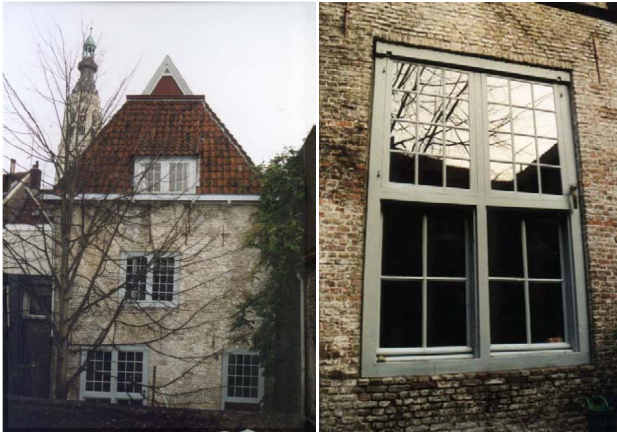
Figuur 60 & 61: Deel van de achtergevel (links) met half zichtbaar het raam beneden (rechts).
