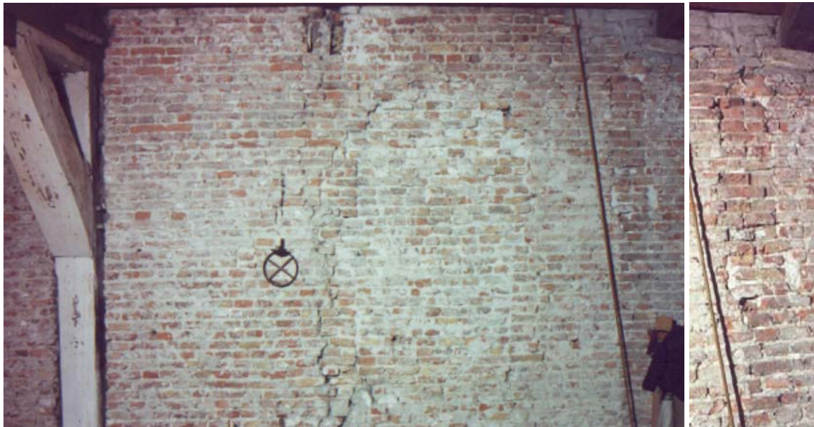
Figuur 119 & 120: Detail van de noordgevel op de eerste verdieping (achterkamer) met links een muurstijl en in het midden en rechts daarvan het dichtgezette raam en geheel rechts sporen van de middenmuurintanding (zie ook detail) (foto E. Koreman 1994).
