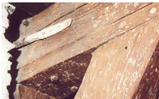
Figuur 105: Moerbalk met telmerk (I) in oksel, muuranker en toognagels (foto E. Koreman 1994).
