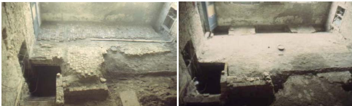
Figuur 68 & 69: Het kelderdak voor (links) en na (rechts) de opgraving met links de ingang aangelegd na de uitbreiding van de kelder in 1490-1495 .
