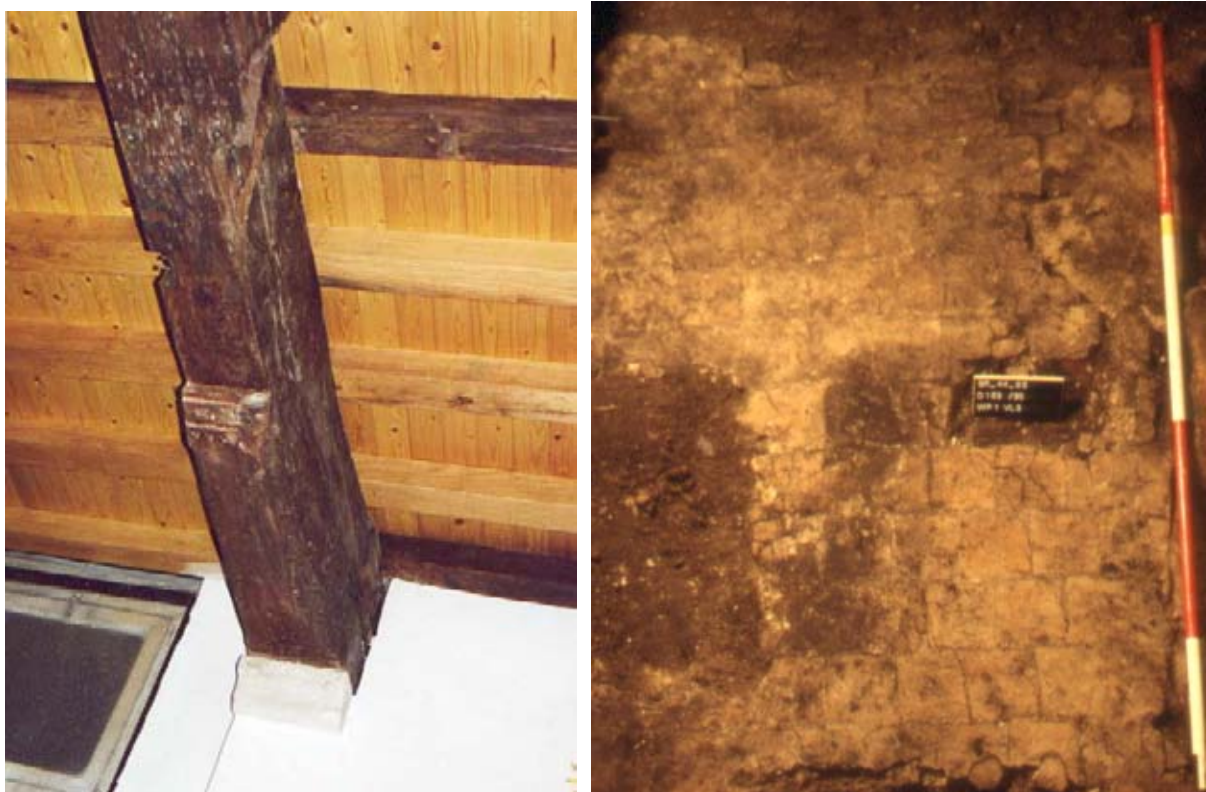
Figuur 76 & 77: De moerbalk beneden voor (links) waaruit een hap is gehaald voor de aanleg van de wenteltrap in 1676 en rechts de vlijlaag (met afdrukken van tegels) waarop de brandlaag van 1490 werd aangetroffen.
