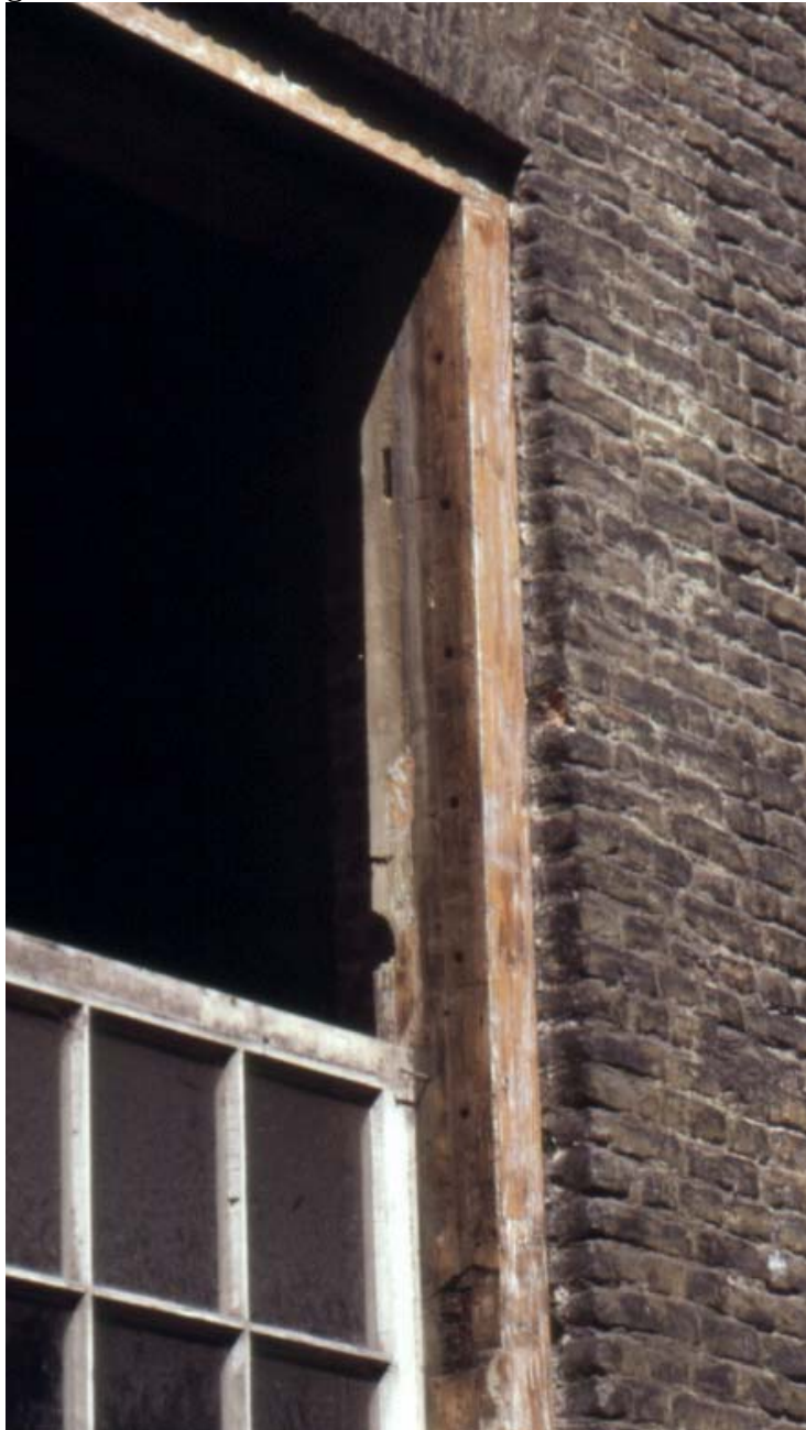
Figuur 86: Foto van de bovenzijde van het raam (ca. 1700-1750) in de voorgevel met in het kozijn het spoor van het kalf en de gaten in het kozijn wijzen op ijzeren roeden van het glas-in-lood raam.
