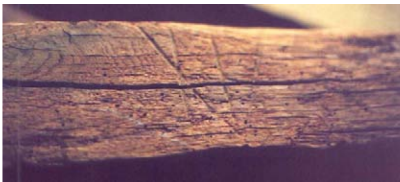
Figuur 121 & 122: Een (timmermans)merk in een spoor in de kap (foto E. Koreman); schematische tekening van merk (rechts).
