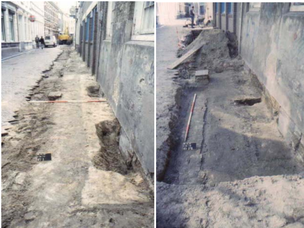
Figuur 133 & 134: De Visserstraat voor het huis Visserstraat 31 tijdens het archeologisch onderzoek voorafgaande aan de vervanging van de riolering: links een verkleuring ter hoogte van de keldergaten en rechts een lichte bakstenen fundering van de riolering uit 1867.
