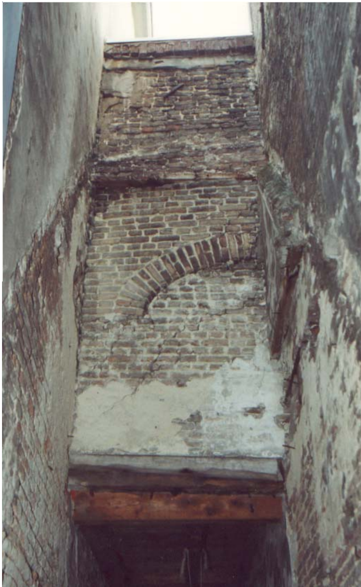
Figuur 45: De steeg was oorspronkelijk twee keer zo breed hetgeen nog te zien is aan de ontlastingsboog en de overbouw (rechts is Visserstraat 33, links de noordgevel van Visserstraat 31) (foto E. Koreman 1994).
