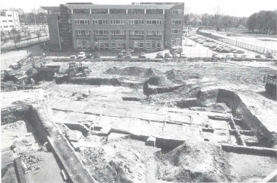
Tijdens de eerste fase van het onderzoek zijn ten oosten van de Kloosterkazerne de 17de-eeuwse soldatenbarakken over een grote oppervlakte vrijgelegd en onderzocht
