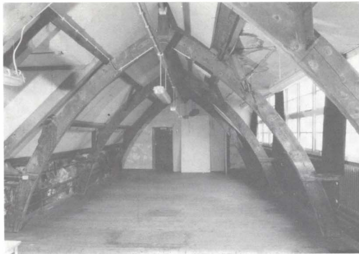
De kap van de oostvleugel is opgebouwd uit Philibertspanten, een bijzonder type dat ook bij de 19 de-eeuwse nieuwbouw van de Kloosterkazerne is toegepast.
