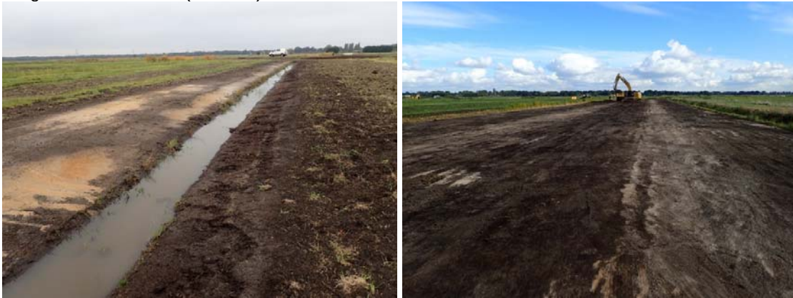
Afbeelding 5. Links de herprofilering van de sloten, rechts de verlaging van de weilanden.
