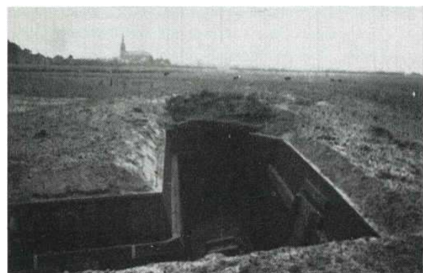
Afbeelding 3. Loopgraaf met een machinegeweerstelling aan het einde, gelegen aan de Bieberglaan (gemeente Breda). Op de achtergrond is de kerk van Ulvenhout te zien.
