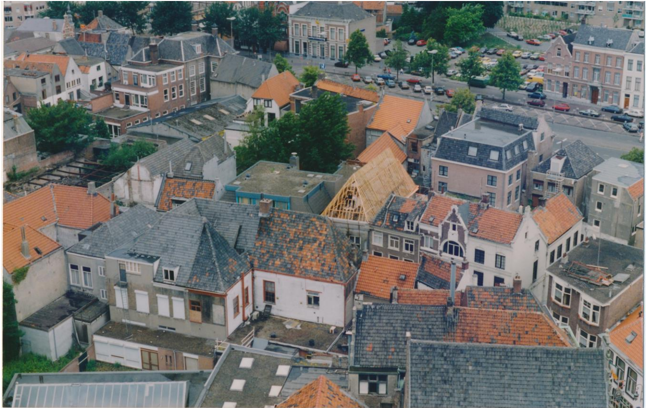
Foto 7. Dak vanuit de toren
