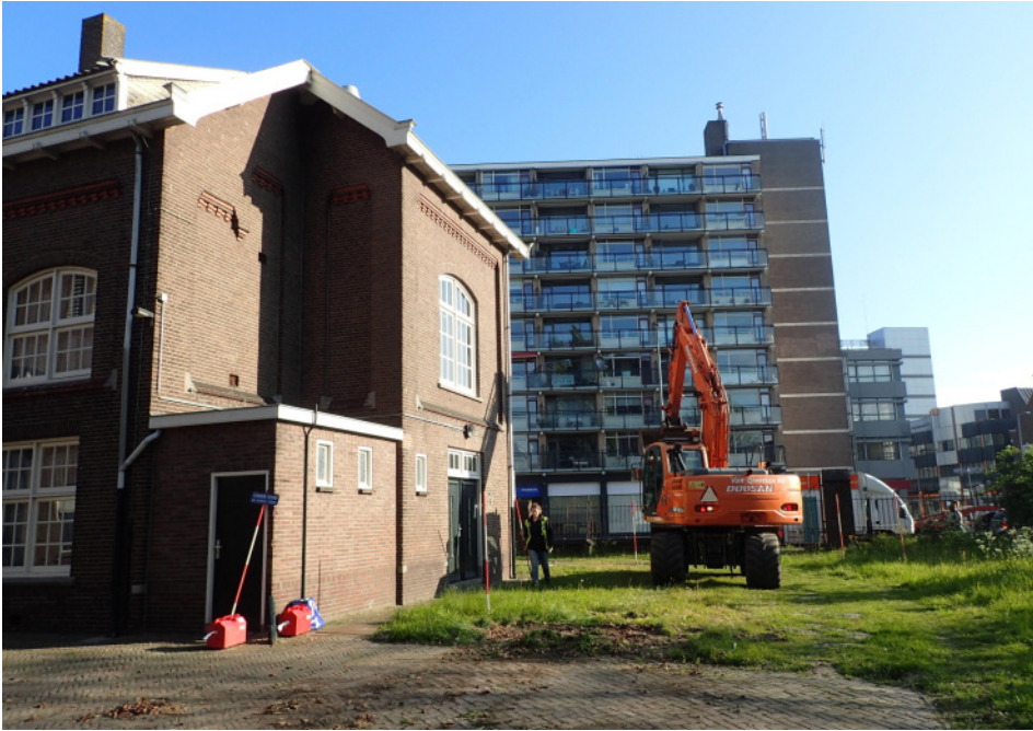
Afb. 8. Aanvang van de werkzaamheden in het noordoosten van het plangebied.
