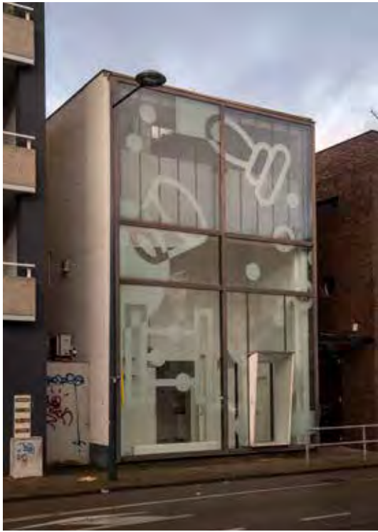
Deel van de voorgevel
