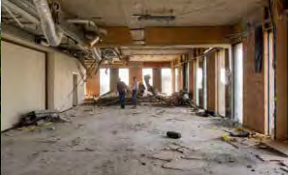
De sloop voor de transformatie
