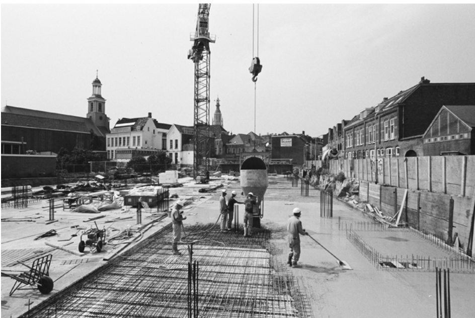
Afb. 4. Bouw van de Nieuwe Veste in juni 1992. Foto: Johan van Gorp, Collectie Stadsarchief Breda, id.nr. JVG199206XX022.
