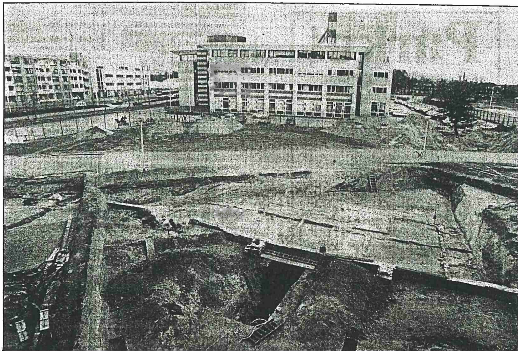
• Duidelijk zijn bij de opgravingen de restanten van de soldatenbarakken te zien.
