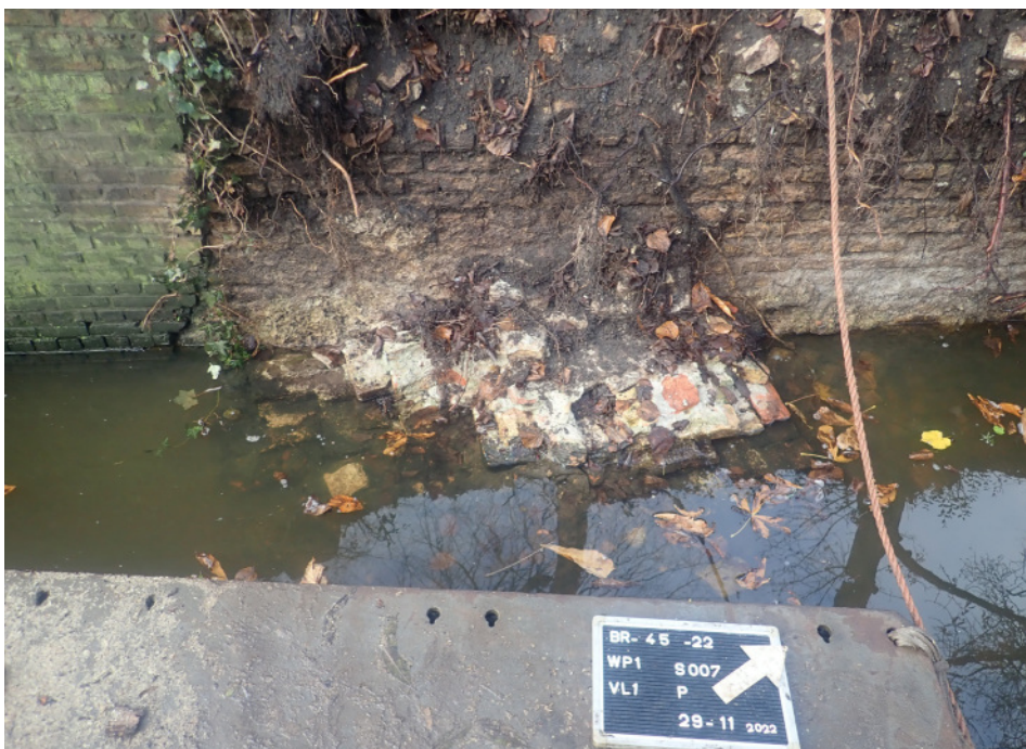
Afb. 15. Onder de muur S 002 vulling 1, is aan de onderkant een uitstekend muurdeel te zien (S 007). In het water is vaag de halfronde vorm van dit muurwerk te zien.
