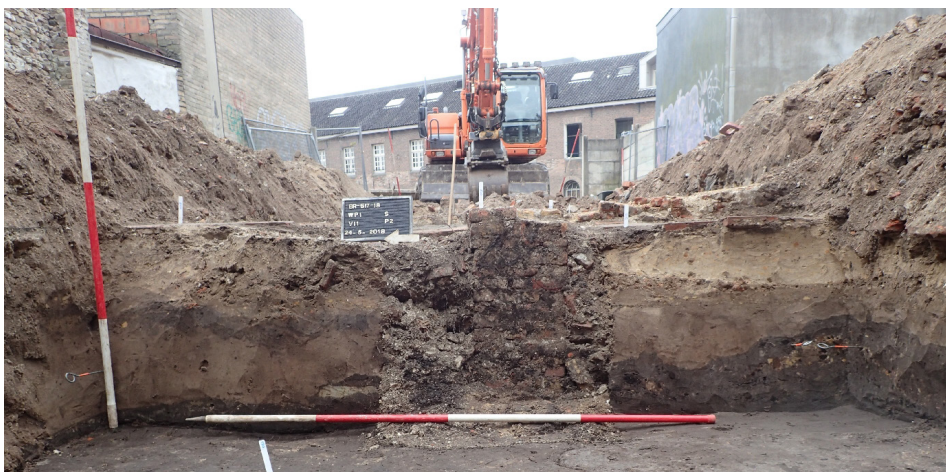
Afb. 8. Een overdwars (N-Z) profiel kon worden aangelegd in de westelijke helft van de werkput (profiel 1-1-2).
