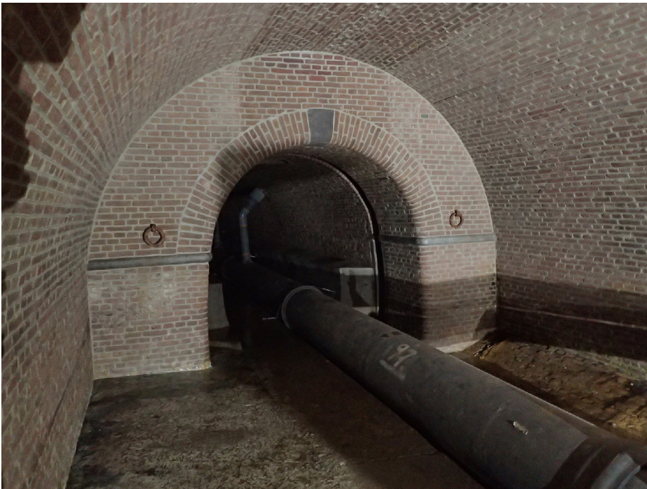
Afb. 6. Foto van de binnenzijde van het gerestaureerde historisch riool ter hoogte van de Houtmarkt-Ginnekenstraat.
