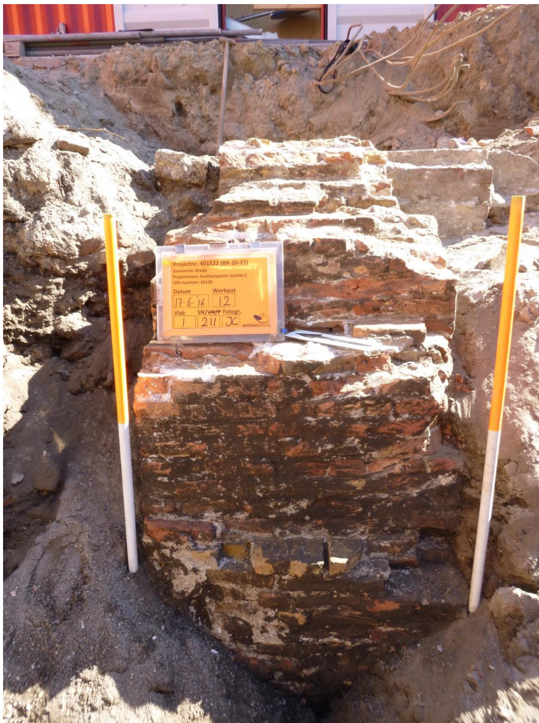
Afbeelding 34. Kademuur met steunbeer in werkput 12 (foto: Antea Group).
