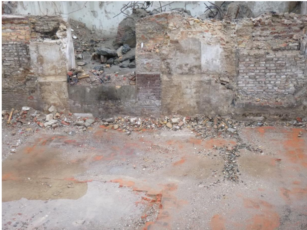
Afbeelding 30. Foto van de kelderpartij in werkput 10
