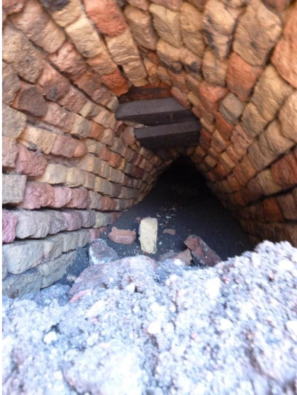
Afbeelding 35. Een doorkijk in het overkluisde gewelf dat is aangetroffen in werkput 12.
