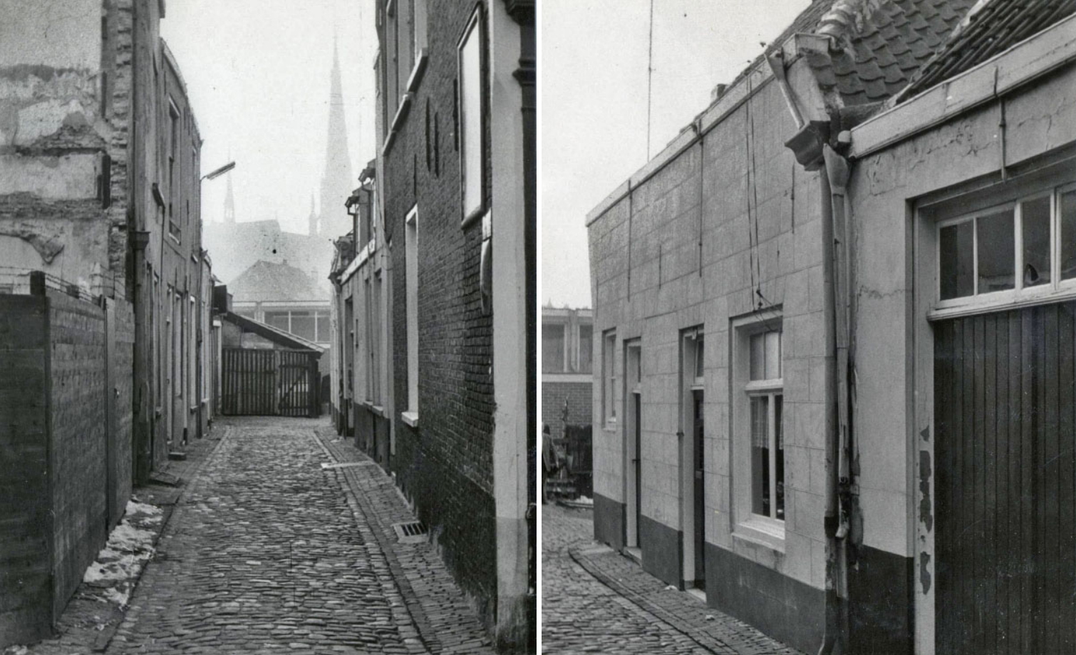
Afb. 9 en 10. Links de Kleine Molenstraat, gezien vanuit de Molenstraat, vlak voor de afbraak van het gehele bouwblok. Rechts de boerderij van Feskens, rechts aan het eind van het straatje. Onder deze bebouwing werden bij opgravingen in 1982 dertiende eeuwse bouwsporen gevonden. (Foto's: H.A. Hagen, coll. Stadsarchief Breda , id. 9640003 en 9640002)
