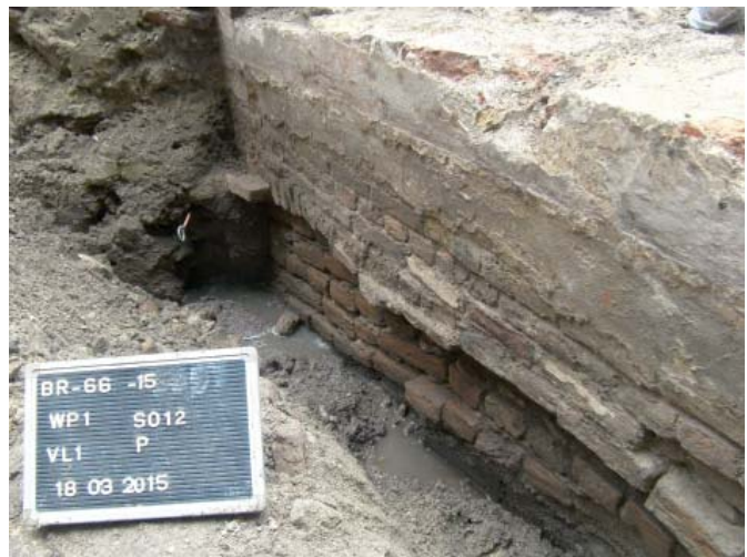
Afb. 13. Zijaanzicht van de binnenzijde van de westelijke keldermuur. Duidelijk te zien is dat de binnenzijde is aangesmeerd en dat er een oudere muur onder ligt. Ook is de rollaag zichtbaar.
