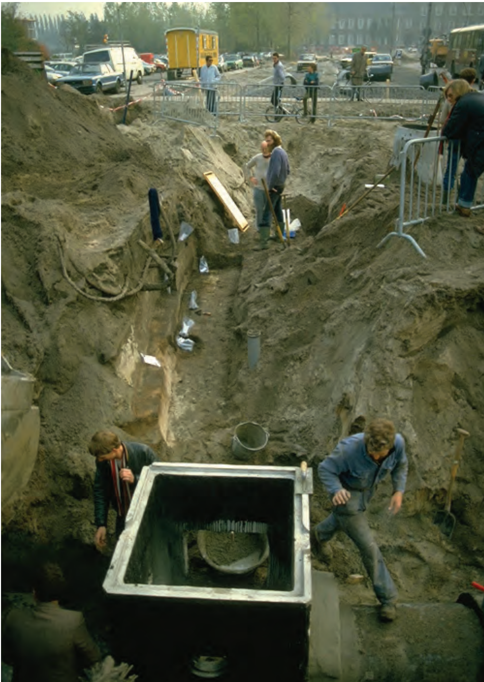
Afb. 1.05: Aanleg nieuwe hoofd- riolering Boschstraat/ Vlaszak 1983. Op de achtergrond het latere opgravingsterrein.
