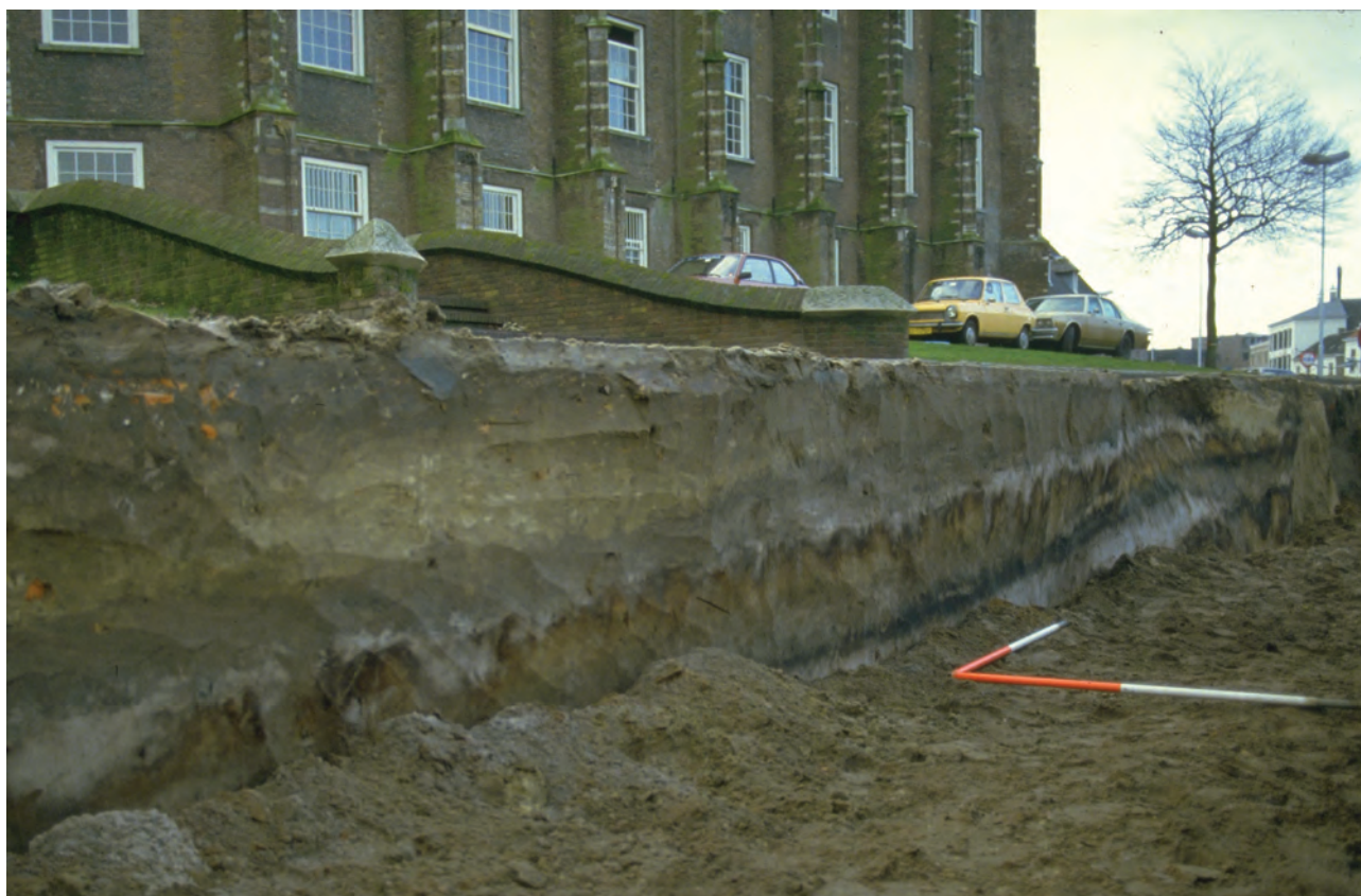
Afb. 1.07: Aanleg hoofdriolering in 1983 voorlangs de Kloosterkazerne.
