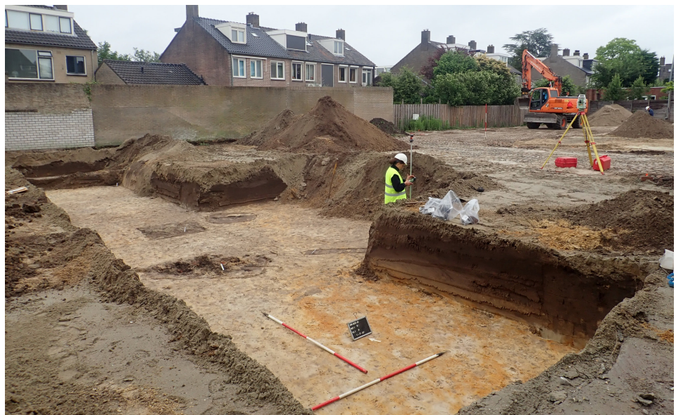
Afb. 4. Aanleg en documentatie van de werkputten.
