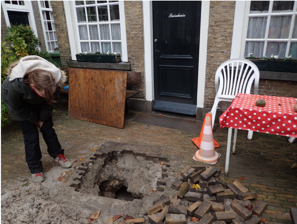
Afb. 12. De ligging van de waterkelder (S 009) zoals deze bij werkzaamheden werd aangetroffen.
