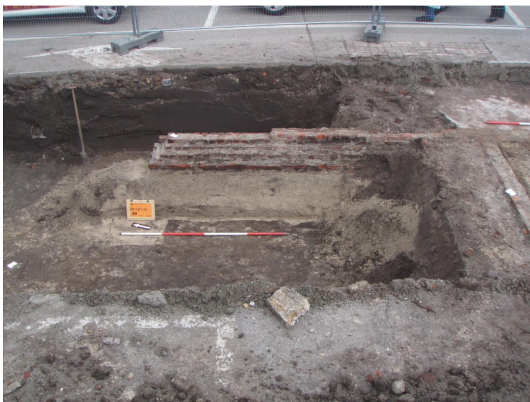
Afb. 89 Getrapte fundering (muurdeel S38) van de boerderij van Claassen.
