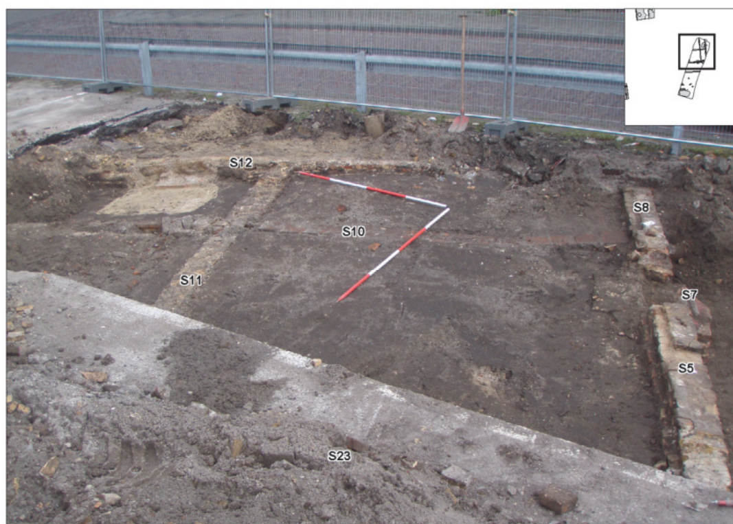
Afb. 73 Muurresten van bebouwing uit de 19 e of 20 e eeuw in proefsleuf 5.
