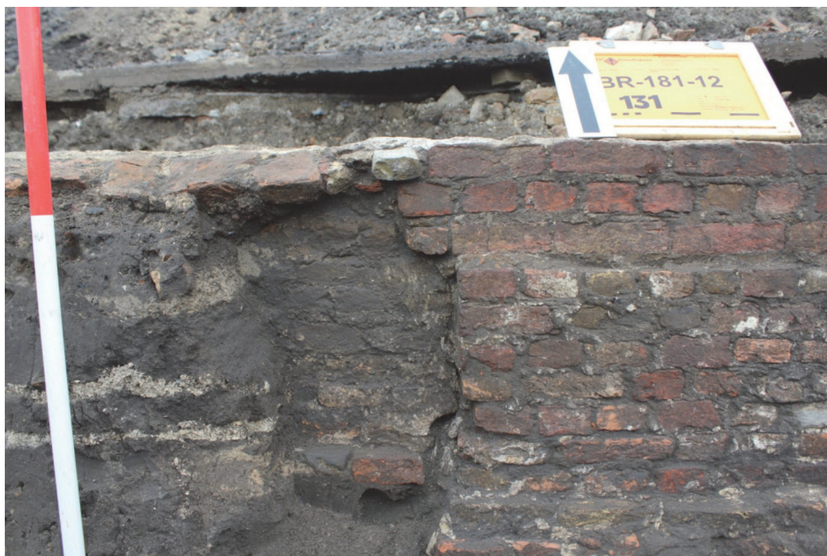
Afb. 112 Detail van reparatiewerk aan de fundering van de timmerloods.
