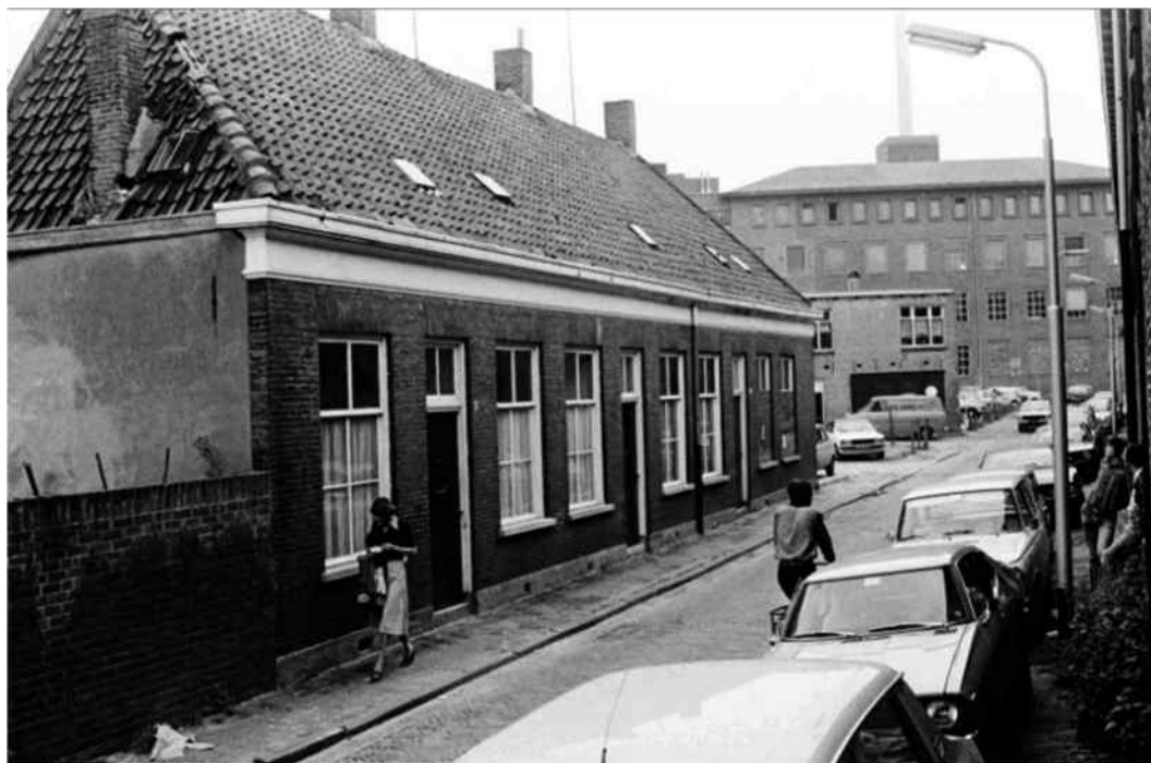
Afb. 21 Arbeiderswoningen in het midden van de Achter de Lange Stallen. (Bron: SAB, Breda Beeldcollectie JVG19780712005)
