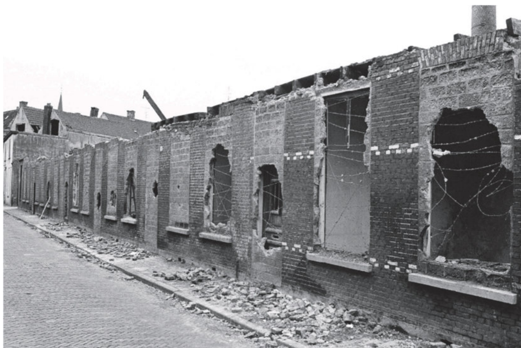
Afb. 20 Sloop van de arbeiderswoningen langs het zuidelijke deel van de Achter de Lange Stallen. (Bron: SAB, Breda Beeldcollectie JVG19710302002)
