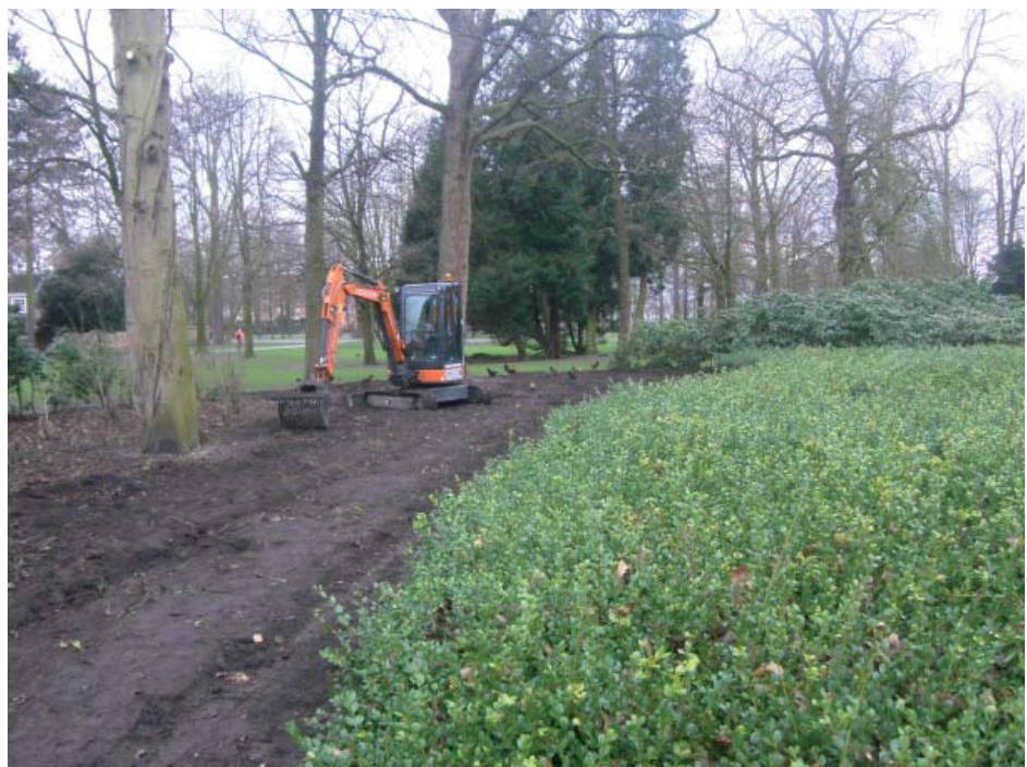
Afb. 11. Graafwerkzaamheden in het plantvak
